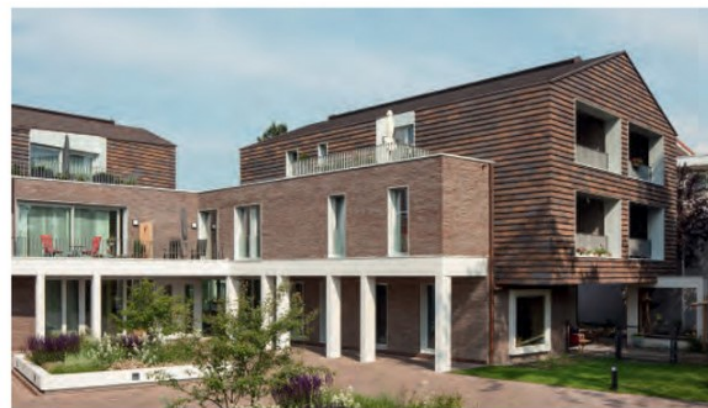
Nur das Erdgeschoss des Vierkandthofs ist zusammenhängend. Nach oben hin bilden die drei Seiten selbständige Gebäudeteile unter einem jeweils eigenen Satteldach.
