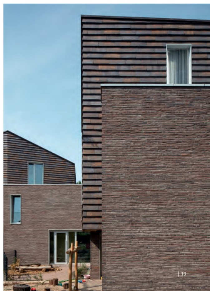
Die Anwendung von Kolumba und Cover in denselben braunroten Farbtönen verbindet das Gebäude, während die unterschiedliche Stofflichkeit der beiden Ziegel einen schönen Kontrast im Fassadenausdruck bildet.
